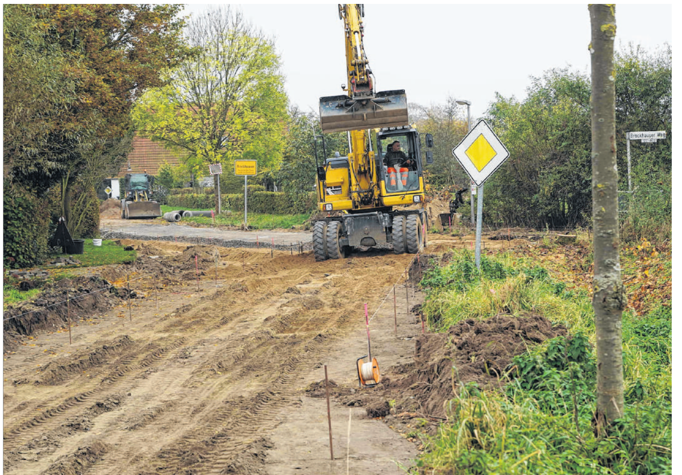
Es wird umgestaltet. Aktuell wird am nördlichen Ortseingang der Ortschaft Brockhausen gearbeitet. Foto: Hubert Dutschek
